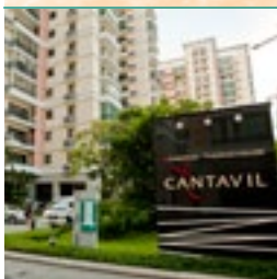
Chung cư Cantavil An Phú (Q.2) (TDH: 40%) Diện tích đất: 10.725 m 2 Đã hoàn thành năm 2006
