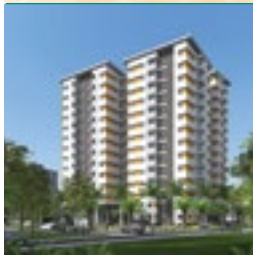
Chung cư TDH - Phước Long (Q.9) (TDH: 100%) Diện tích đất: 3.573 m 2 Đã hoàn thành 2016
