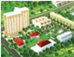
Khu nhà ở TDH - Tocontap (Q.9) (TDH: 70%) Diện tích đất: 16.594 m 2 Đang triển khai xây dựng
