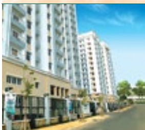
Chung cư TDH - Trường Thọ (Q.Thủ Đức) (TDH: 100%) Diện tích đất: 7.000 m 2 Đã hoàn thành 2010
